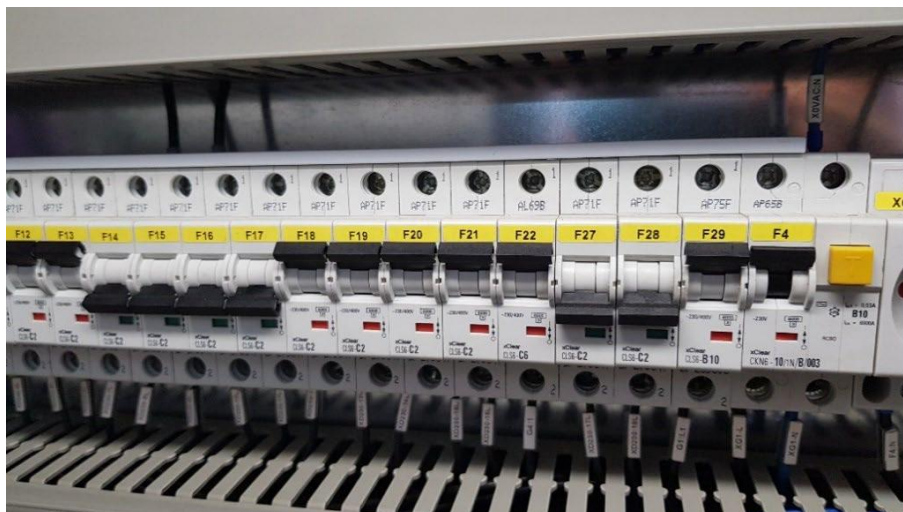
Przykład nr. 4 prawidłowego połączenia zabezpieczeń nadprądowych.
