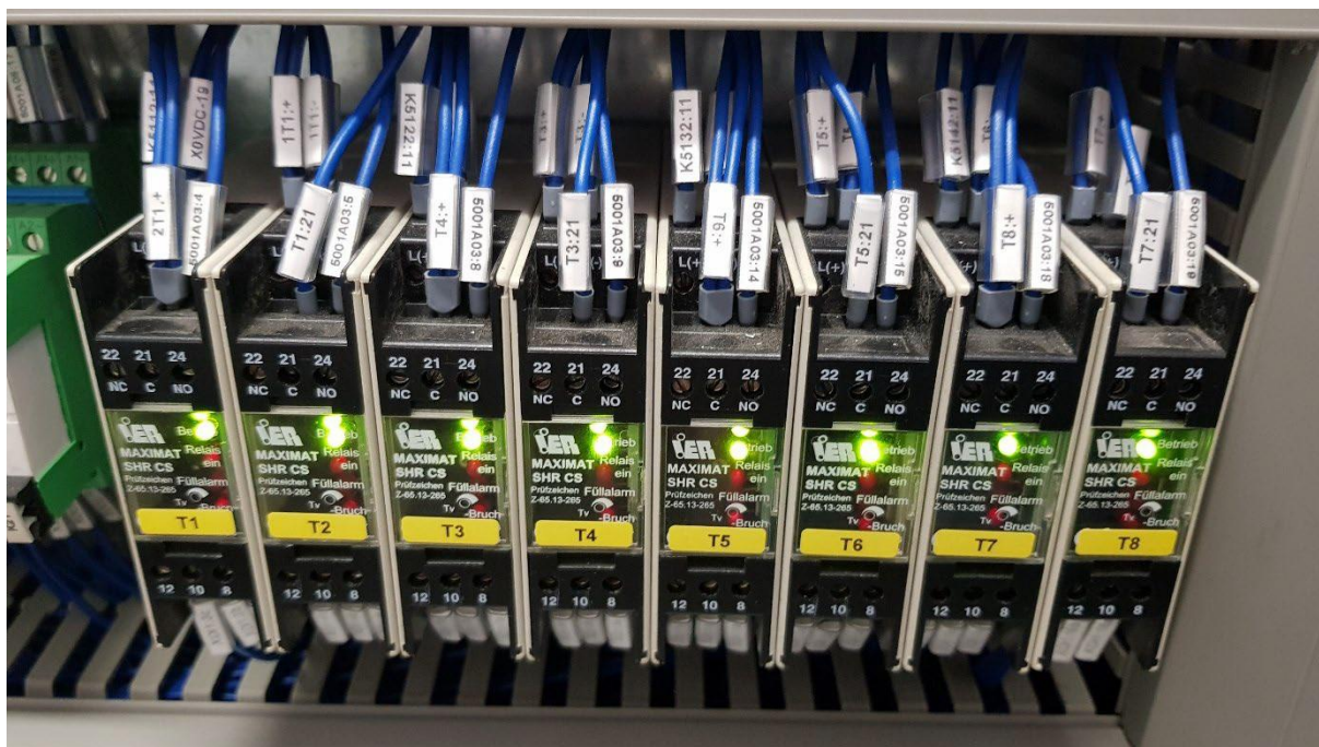
Przykład nr 2. poprawnego typu, poprawnie wykonanych oznaczników.
